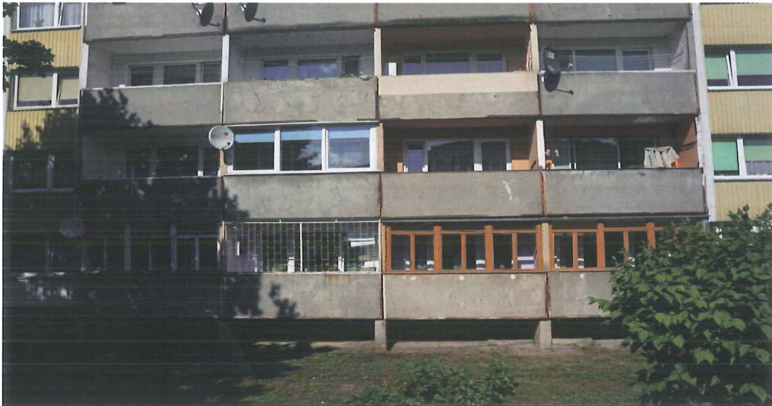
Fot.1. Widok na fragment elewacji z balkonami.
