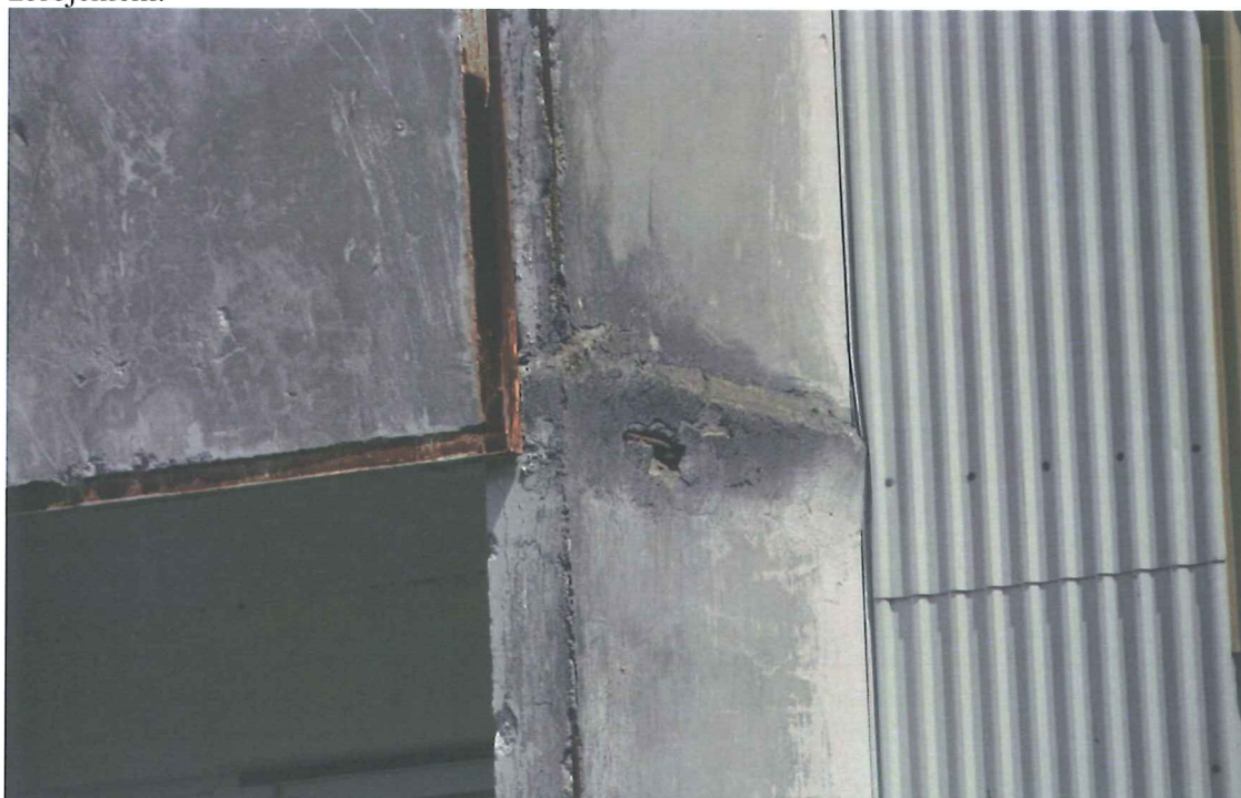
Fot.4. Detal płyty loggii – widoczna balustrad i ścianki osłonowej.
