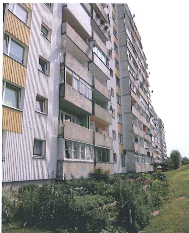
Fot.1.,2.,3. Widoki na fragmenty elewacji z loggiami i balkonami- średni -zły stan techniczny większości balustrad
