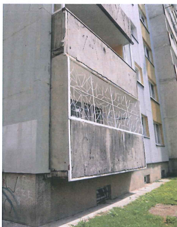
Fot.1.,2.,3. Widoki na fragmenty elewacji z loggiami i balkonami- średni -zły stan techniczny większości balustrad
