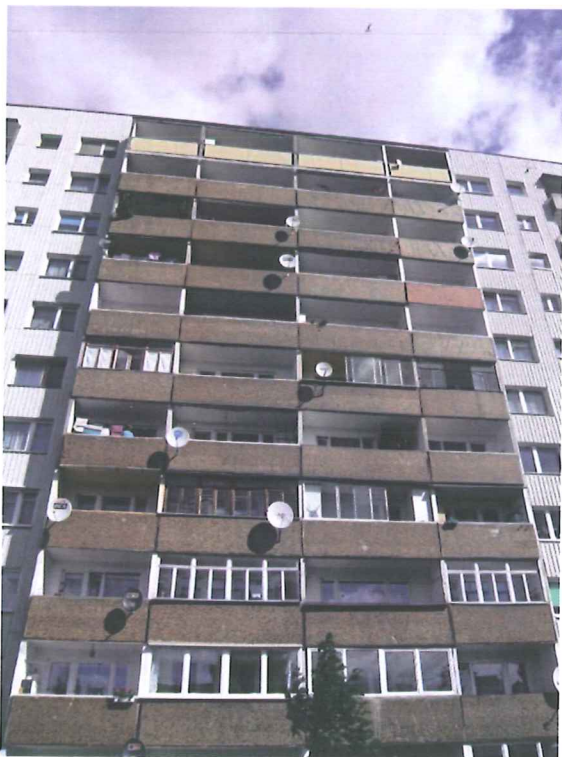
FOT. 1.,2.,3. Widoki na fragmenty elewacji z loggiami i balkonami- średni -zły stan techniczny większości balustrad.
