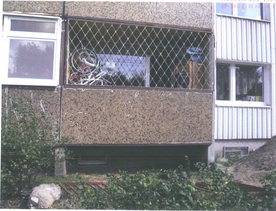
FOT.4. Widok loggii z balustradami z fakturowanym wypełnieniem.
