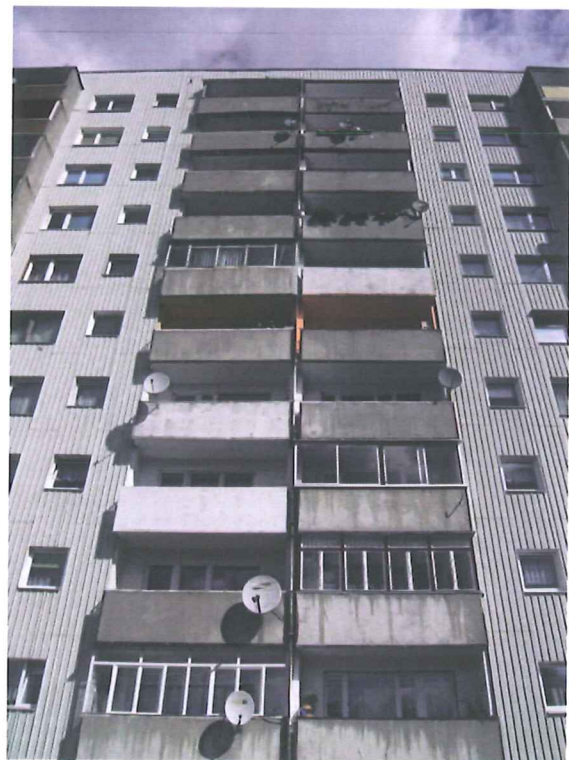
FOT. 1.,2.,3. Widoki na fragmenty elewacji z loggiami i balkonami- średni -zły stan techniczny większości balustrad.
