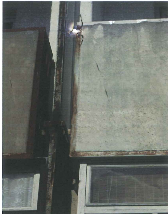
Fot.4. ,5. Widok loggii –korozja elementów metalowych oraz płyty z widocznym zbrojeniem.
