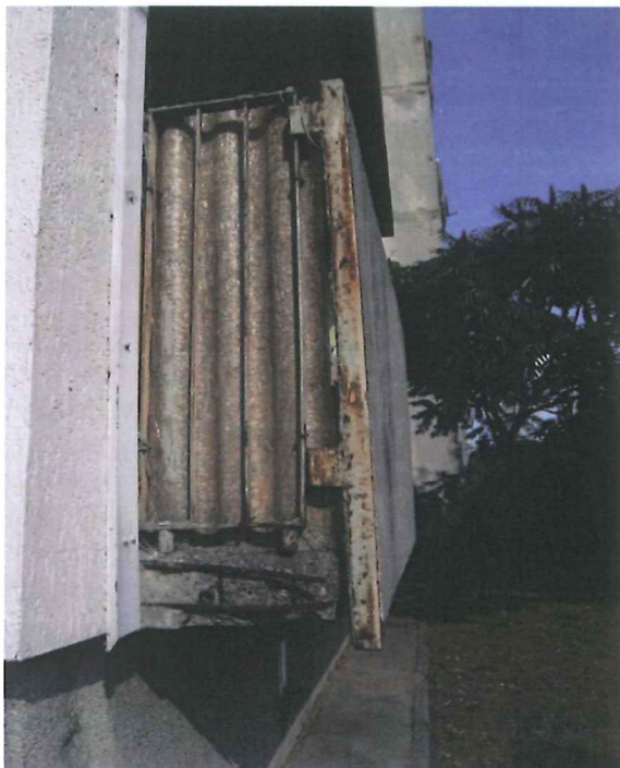
Fot.1. Widok na fragment elewacji z loggiami - średni -zły stan techniczny większości balustrad loggii.
