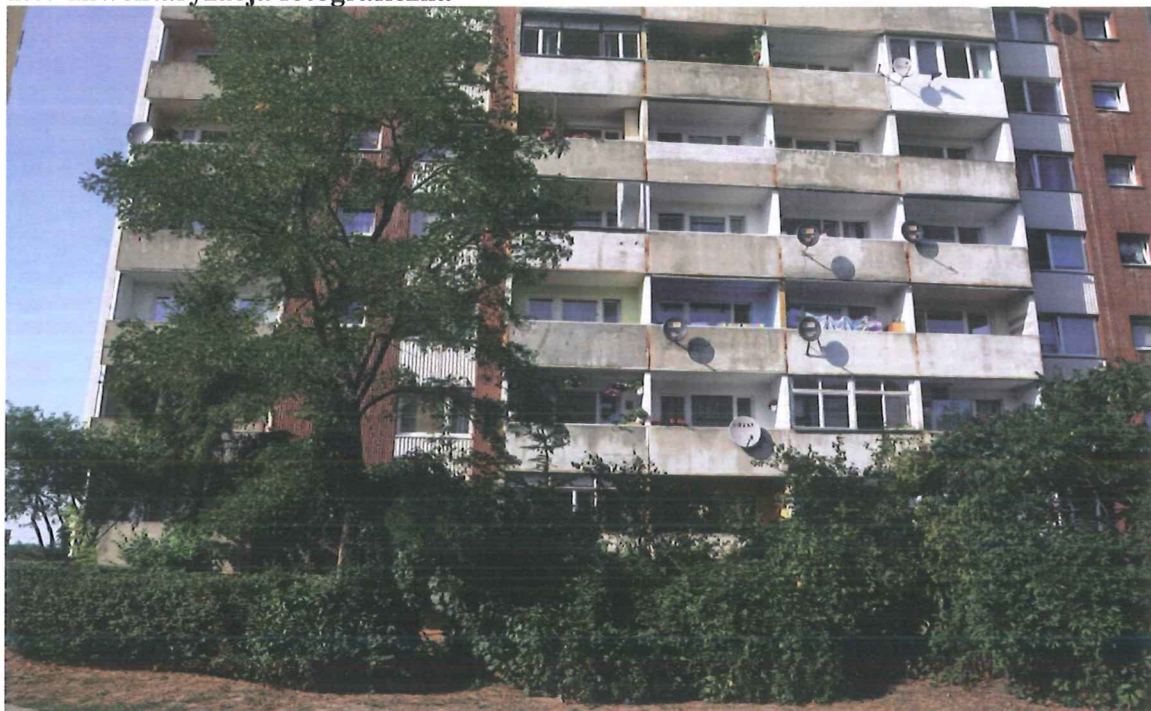
Fot.1. Widok na fragment elewacji z loggiami - średni -zły stan techniczny większości balustrad loggii.
